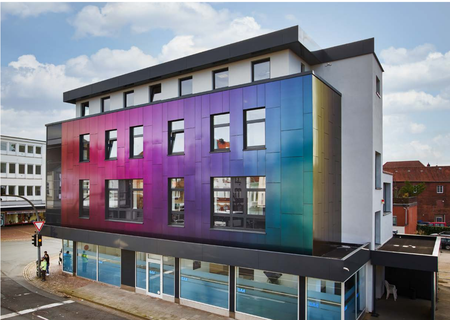
Projekt: Renowacja budynku biurowego, Nienburg, Niemcy
